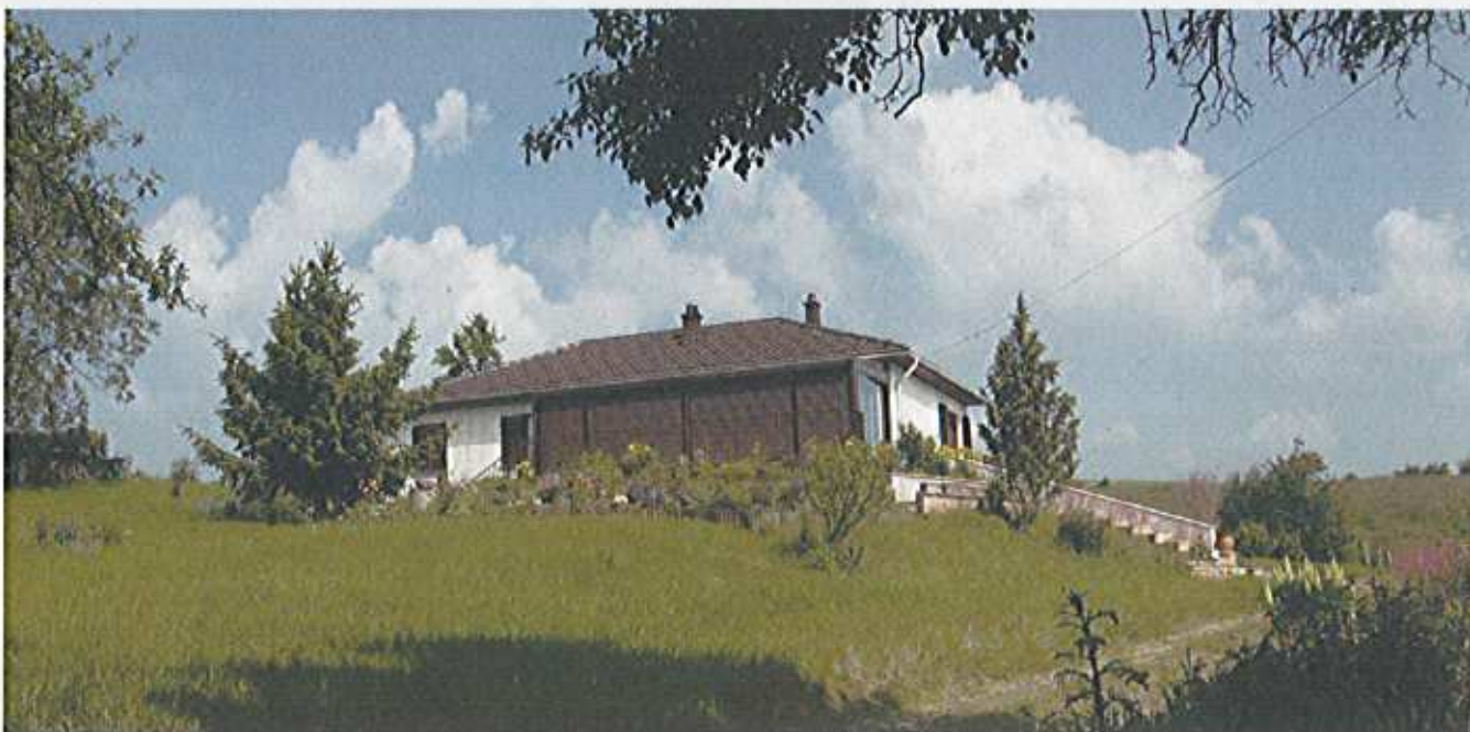
Maison de 1970-1980 rue du château à Charleville-sous-Bois
