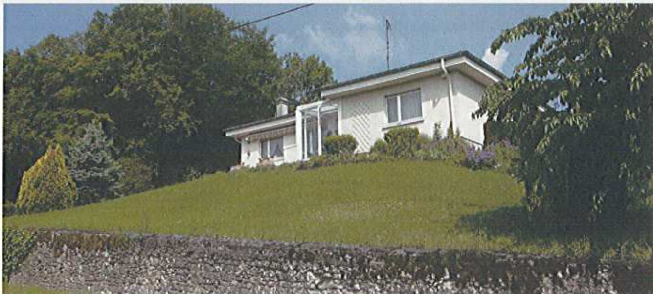
Maison de 1970-1980 rue du château à Charleville-sous-Bois
