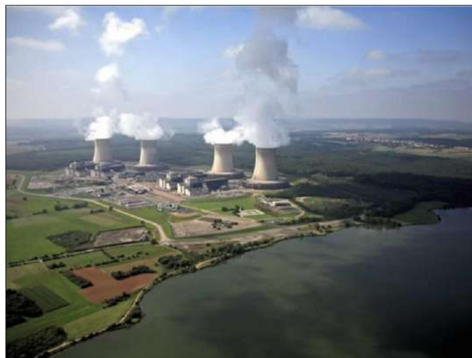
Photo aérienne du CNPE, source EDF
