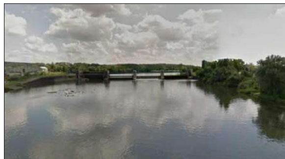
Pont Koenigsmacker avec microcentrale électrique
