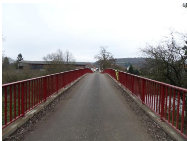
Pont routier à Blies-Guersviller
