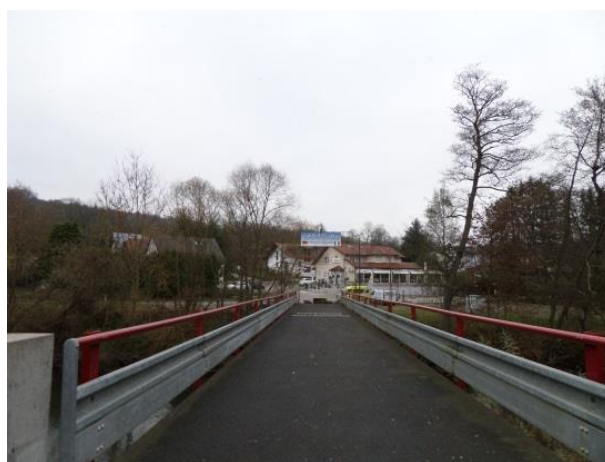
Pont piéton et cycliste à Blies-Schweyen
