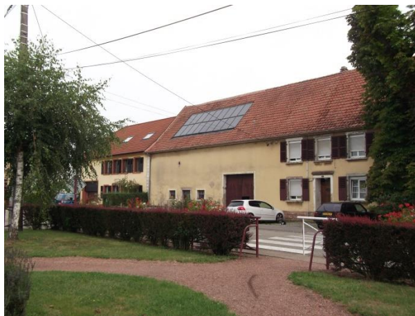
Panneaux solaires intégrés dans une toiture
