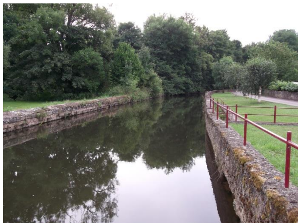
Canal d'aménée vers l'usine hydro-électrique
