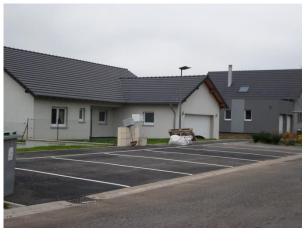
Espace de stationnement dans le lotissement
