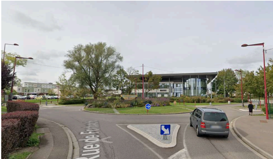
Entrée de ville est, depuis la rue de Sarreguemines, en faisant face au nouvel hôtel de ville.
