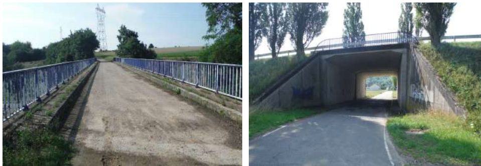
Passages supérieur et inférieur le long de la RD31 bis
