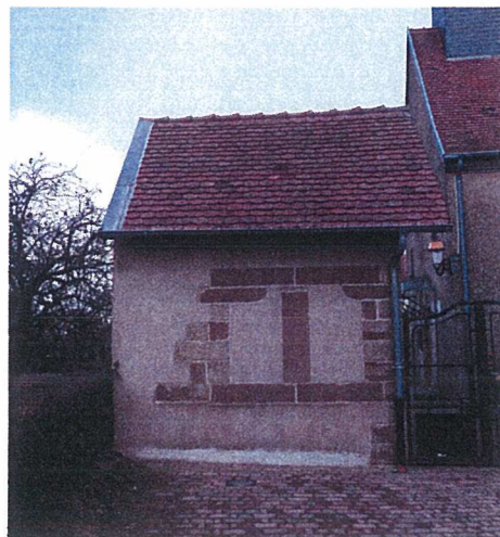
Façade Sud de l'ossuaire
