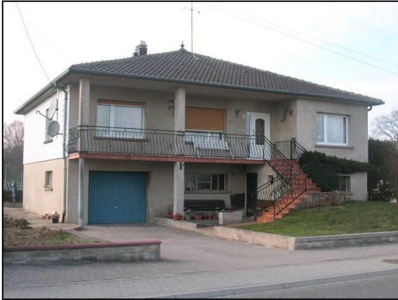
Un des premiers pavillons, rue Principale : toit à 4 pans, grand balcon, entrée à l'étage.
