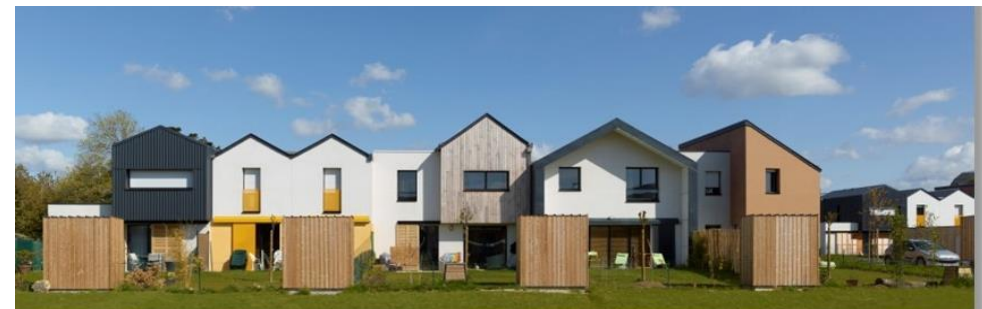
Opération groupée « Vert Buisson » à Bruz (35)
