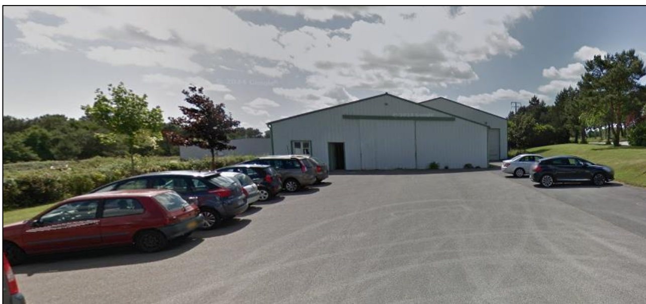
Bâtiment ouest du site de Sulniac.
