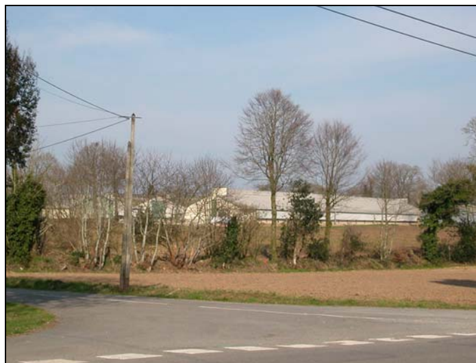
Des bâtiments d'élevage bien intégrés dans le paysage
