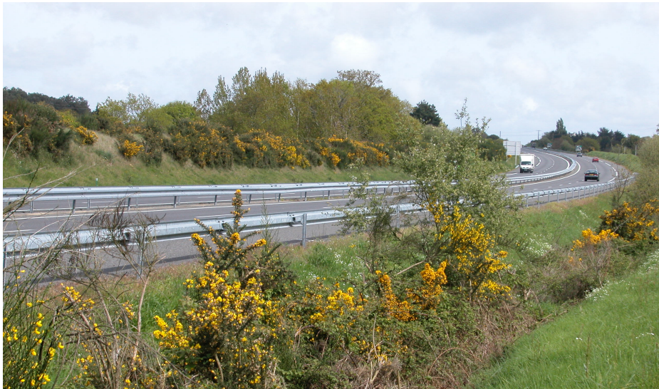
Une infrastructure qui coupe le territoire communal
