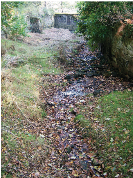
Aval de l'écoulement en période sèche (mi-octobre 2009).
