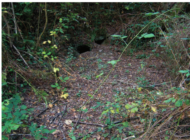
Entrée de la buse passant sous la route d'Auray en période sèche (secteur amont - mi-octobre 2009).
