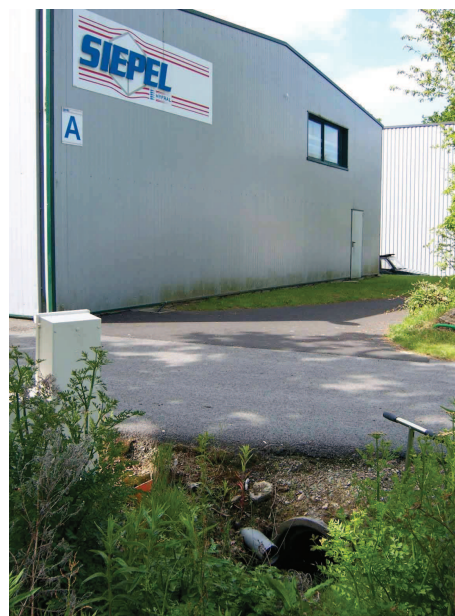
Entrée de buse passant sous le PA de Kermarquer (mi-octobre 2009).
