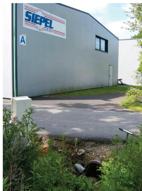
Aval de la zone humide au passage du ruisseau en souterrain sous le PA de Kermarquer.
