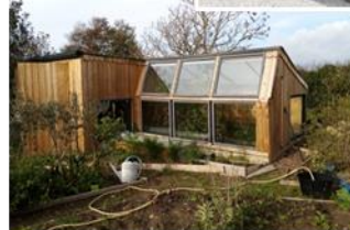
Après : construction d'une serre de jardin
