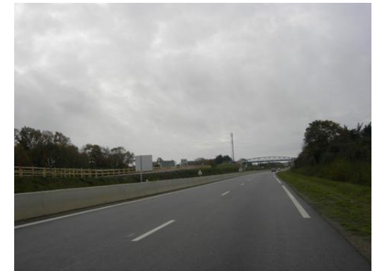
Aménagement piéton pour accéder au Bourg
