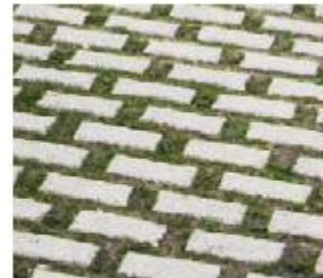
Pavage en béton avec ouvertures de drainage
