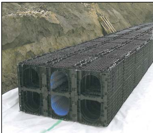
► Structure alvéolaire ultralégères hydro-curable pour rétention et infiltration (RAUSIKKO®- BOX - REHAU)
