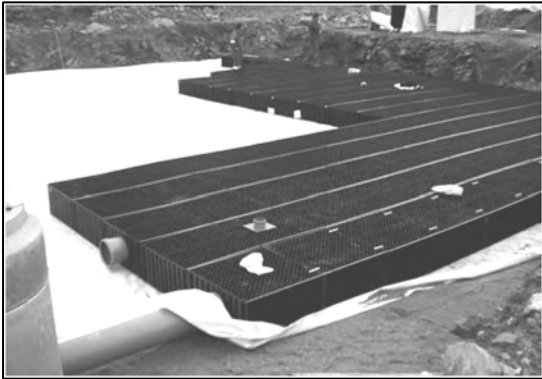
► Système D-Raintank® Chantier à Vannes
