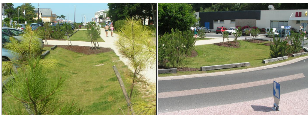
Photo 3 : Exemple de réalisation de noues paysagères
