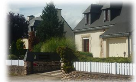
Réalisation de muret en pierre
