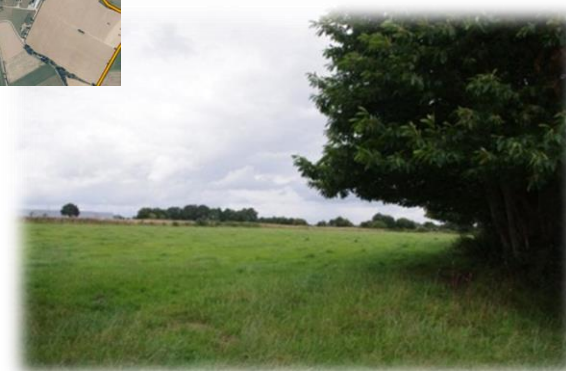
Les bâtiments de Kermené, encaissés, plats et gris, apparaissent discrets dans le paysage malgré leur très grande emprise.
