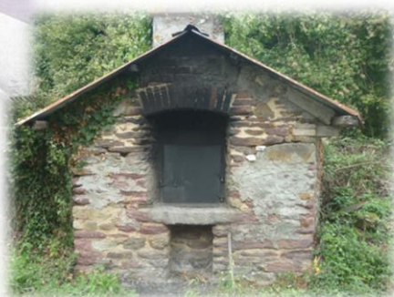
Four situé sur la rue des Closiaux
