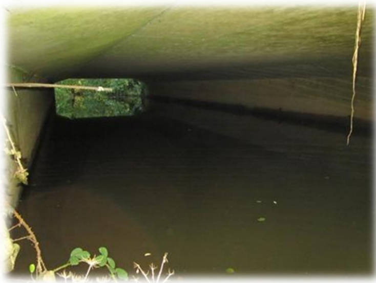
Figure 9 : Passage du Douëff sous la RD 766. Le passage ne permet pas à la faune terrestre de traverser sous la route à sec (=Risque de collision)
