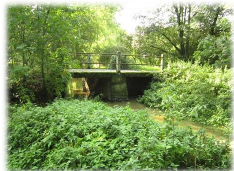
Figure 10 : Dans le bourg de Saint Léry les ponts ne posent pas de problème de continuités écologiques. La faible circulation limite les risques de collision.
