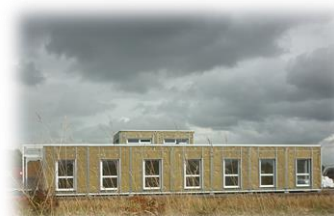
Entreprise Pompéi en construction
