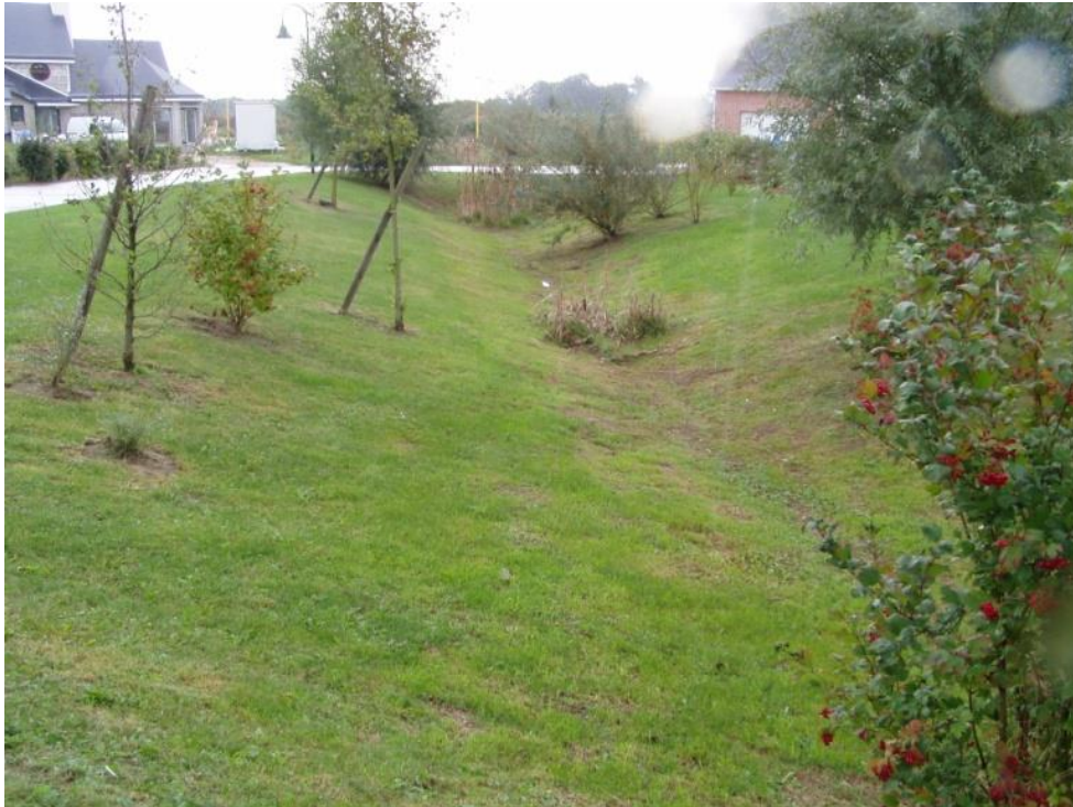
Exemple de noue en lotissement
