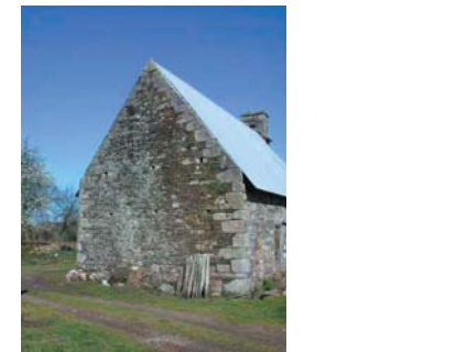
Talforest d'en Haut, pignon en moellon de schiste et pierres d'assise en pierre de taille de granite
