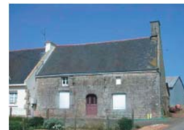
Kerhéro, logis de prêtre
