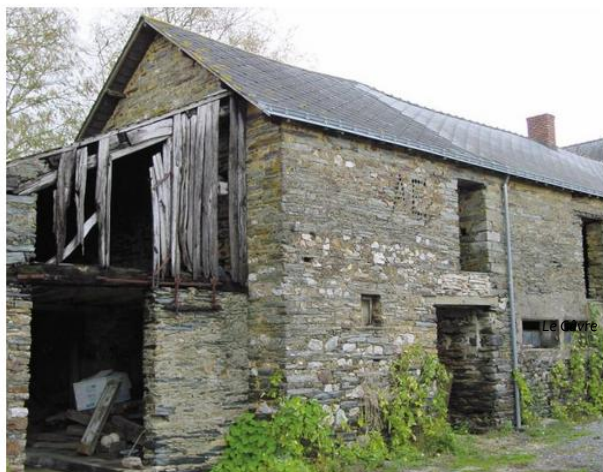
Le corps de ferme avant travaux
