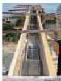
Mise en place d'un chaînage au niveau du repère d'un bâtiment
