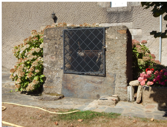
Puits de La Pariais
