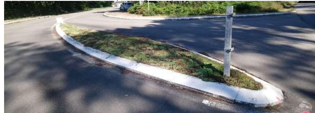
Terre plein végétalisé, Riantec
