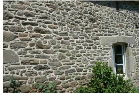
exemple de joints extérieurs chaux/sable
