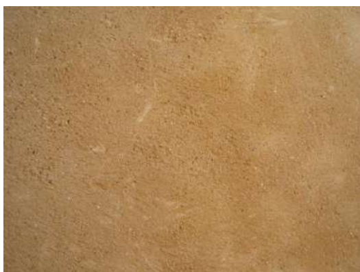
exemple d'enduit de finition à la chaux
