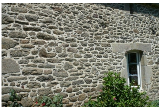
Exemple de joints extérieurs chaux/sable
