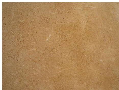
Exemple d'enduit de finition à la chaux
