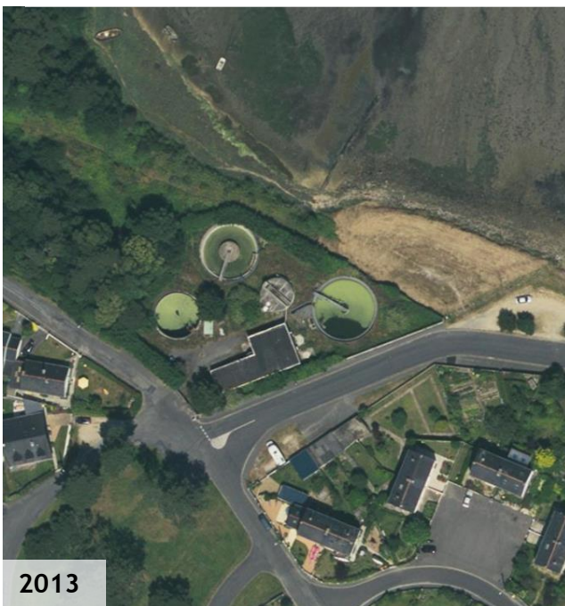
Vue aérienne station d'épuration de Kerzo
