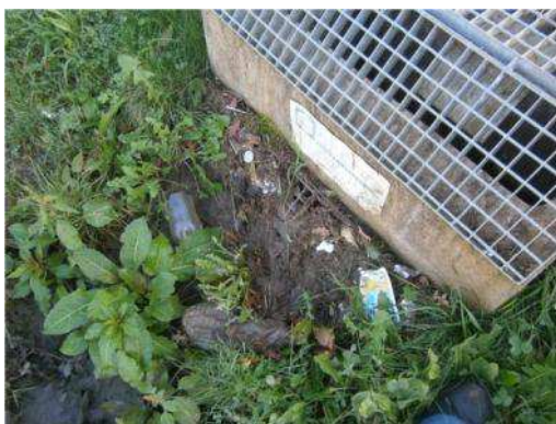
Photo 4 : Ouvrage de régulation au Quintrec
