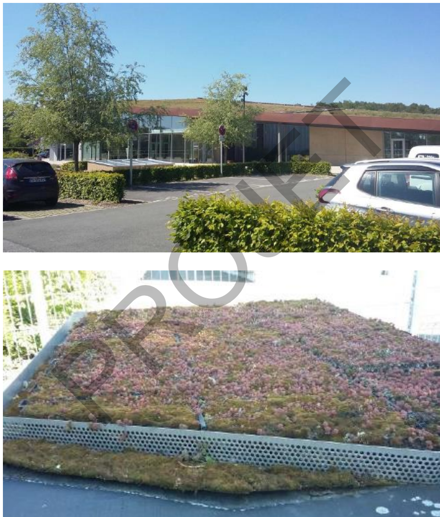
Figure 299 : Illustrations de toitures végétalisées
