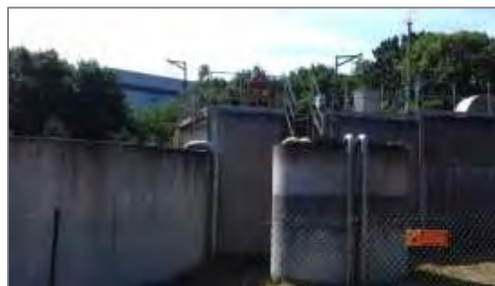
Zone de contact – Bassin d'aération
