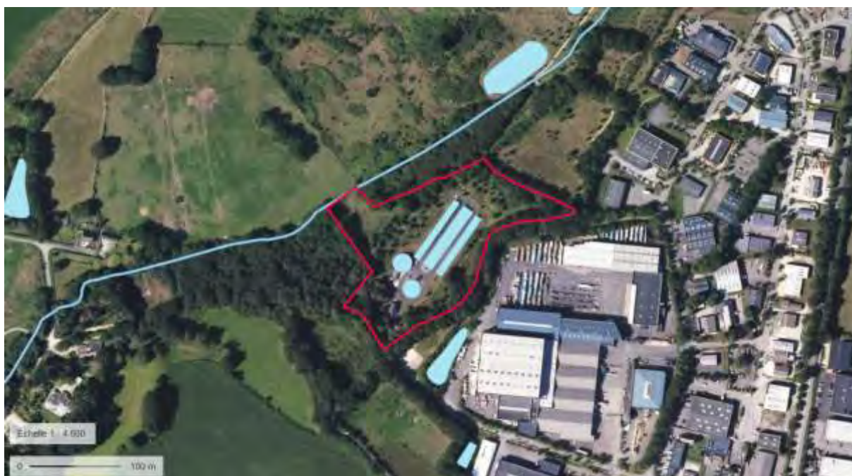
Figure 35: Vue aérienne du site d'implantation
