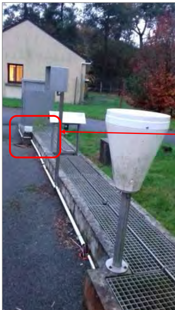
Affaissement de la voirie au niveau du canal de comptage sortie station (débordemens du canal de comptage)
