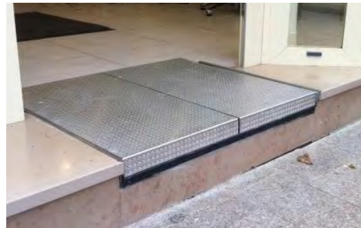
système de rampe escamotable intégré dans la marche d'accès au commerce
