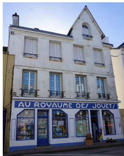
vitrine occupant tout le RDC
