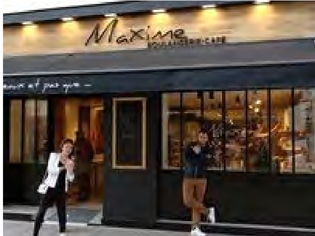
éclairage extérieur rasant, intégré sous la corniche
