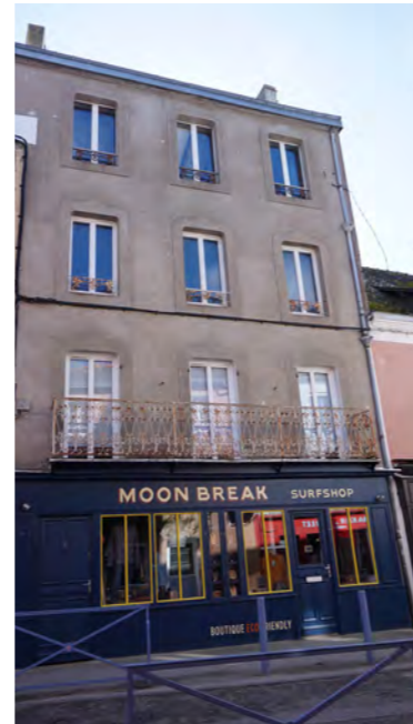
devanture occupant tout le RDC
