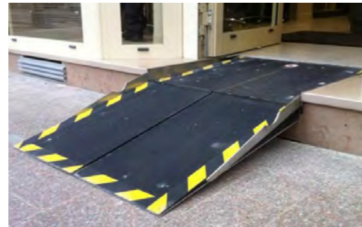
système de rampe escamotable intégré dans la marche d'accès au commerce
