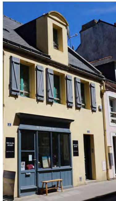
habillage fixé sur le mur
