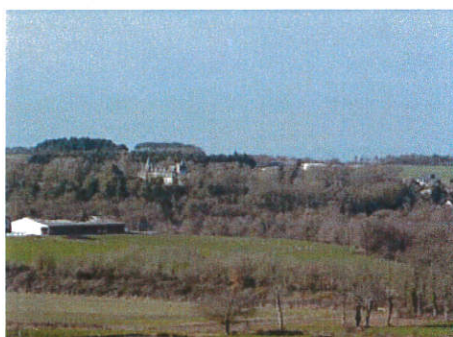
Hangar agricole au pied du Château du Bois de La Roche
