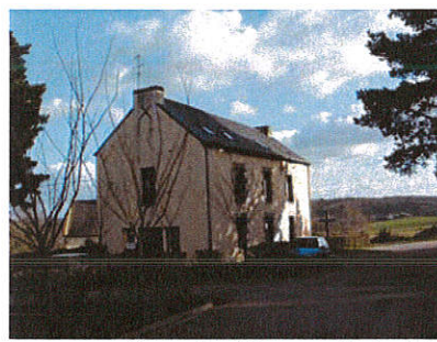
Logements collectifs rue de la Grotte
