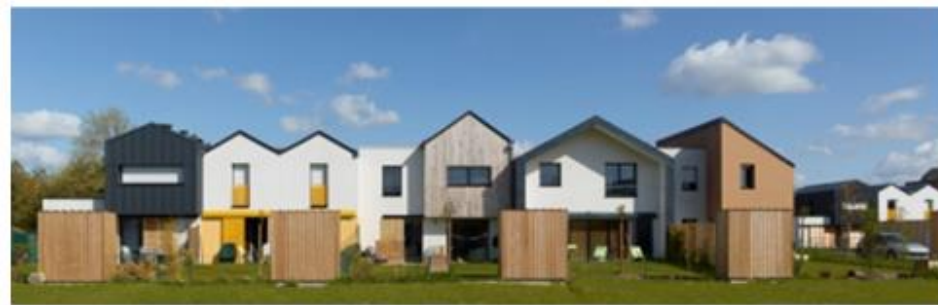
Opération groupée « Vert Buisson » à Bruz (35)
