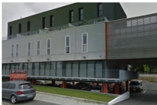
Logement Collectif et bureau – Auray (56)
