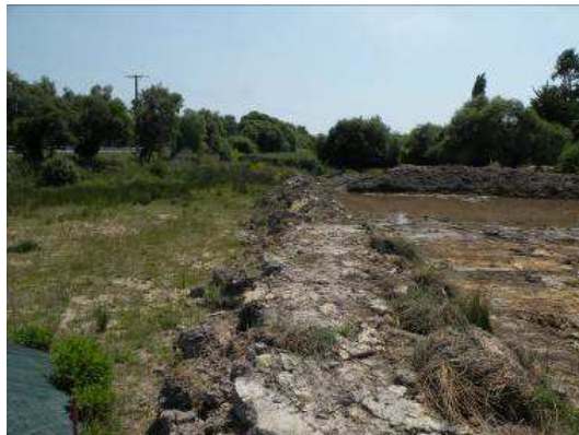
Remblai sur zone humide au sud de Kerzac'h
