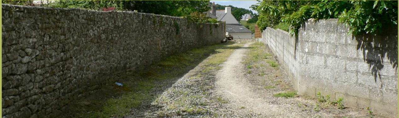
Contraste entre un muret de pierres sèches et une clôture en parpaings non enduits
