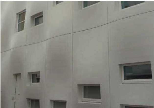
Exemple d'habillage : habillage en Ductal courbe
