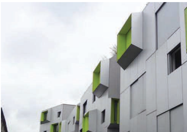
Exemple d'encadrement : métallique en tôle pliée
