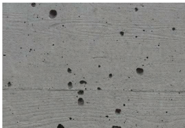
Exemple d'habillage : parement en béton brut de décoffrage
