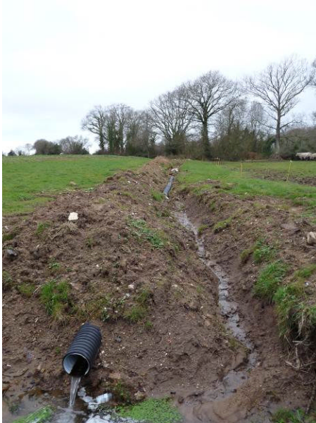
Source captée et busée (Kerdelam)
