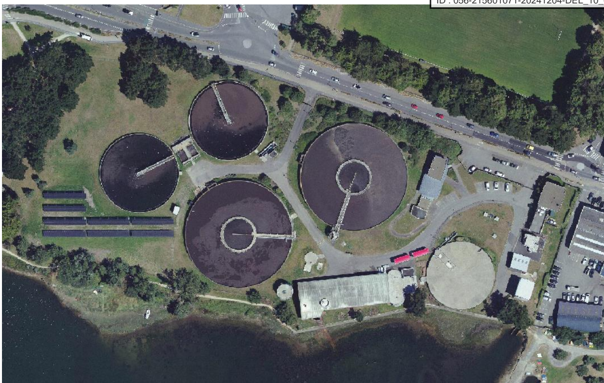
Figure 41 : station d'épuration de Lorient
