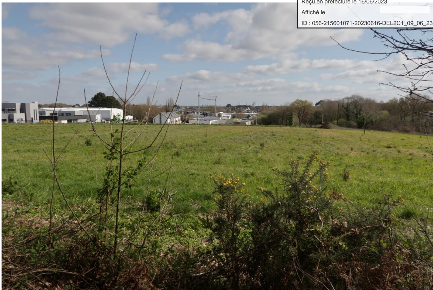
OAP Kerhoas, vue du site depuis le Sud-Ouest en direction de la zone d'activités.
