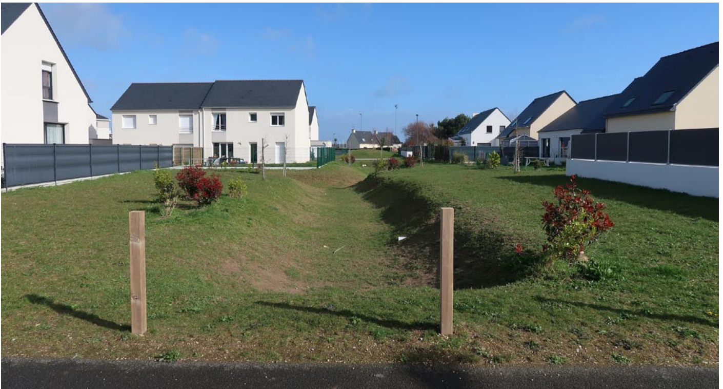
Exemple de noue destinée à retenir et à infiltrer les eaux pluviales.
