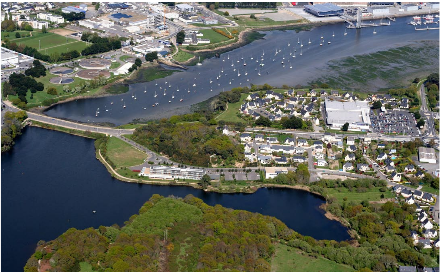
En haut à gauche, la station d'épuration de Lorient - Kerolay, qui traite les eaux usées de Larmor-Plage.
