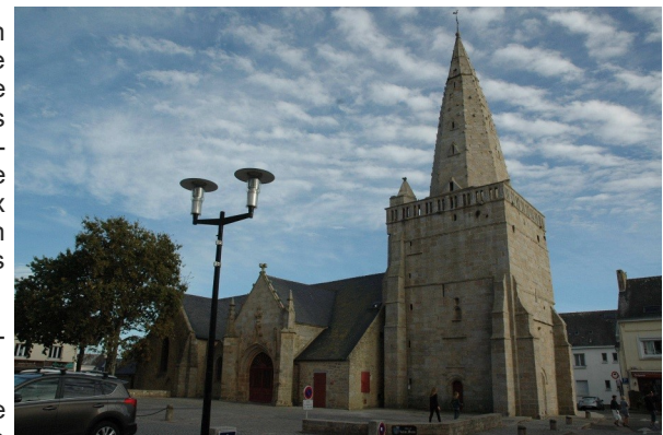
Façade Nord de l'Eglise
