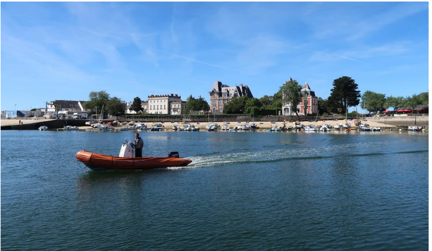
Ensemble de villas balnéaires à la pointe de Kernével.
