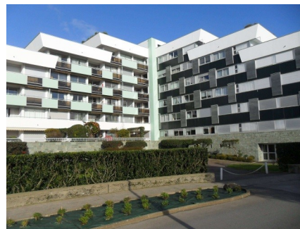
Le « Tripode » à Toulhars, repère dans le paysage littoral larmorien (architecte : René Delayre)
