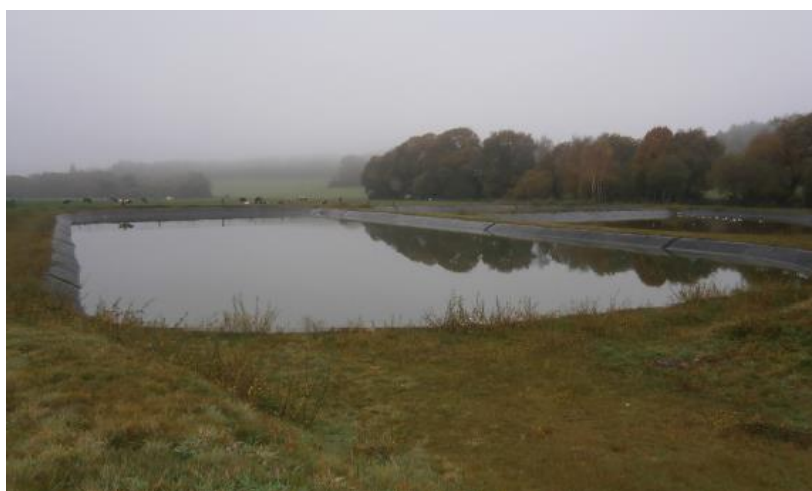
Figure 11 : Vue de la première lagune
