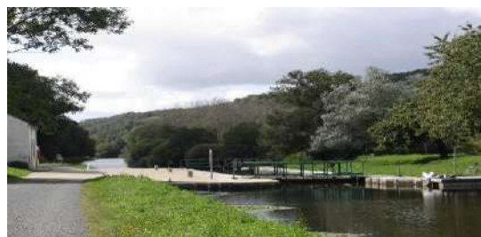
Nord- écluse de Minazen
