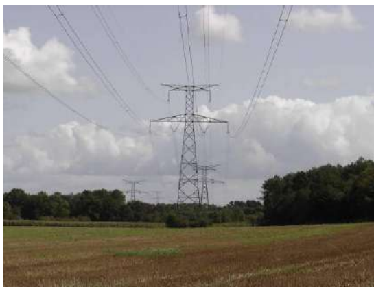
Du sud au nord de la commune...
