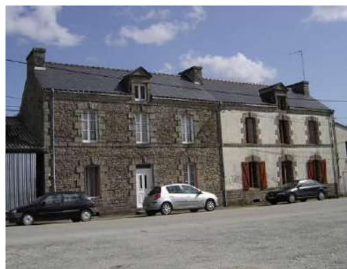
Pont Augan - Maisons entièrement restaurées
