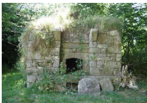
Four à pain de Villeneuve-Kerfily
