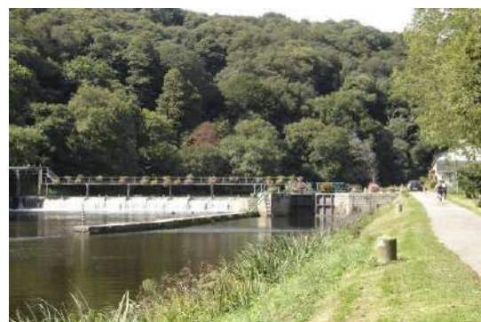
Ouest - écluse de Trébihan
