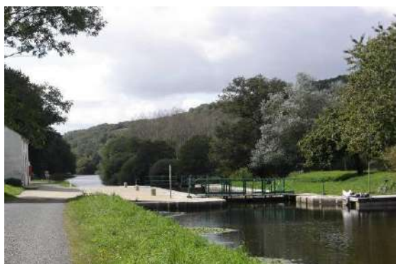
Nord - écluse de Minazen
