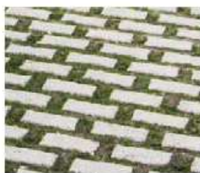
Pavage en béton avec ouvertures de drainage
