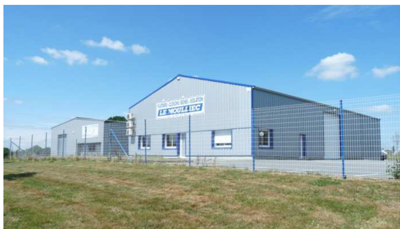
Z.I. du DOUARIN : entreprise LE MOULLIEC
