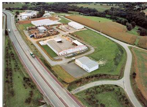
Vue aérienne de la zone d'activités de la CROIX BLANCHE
