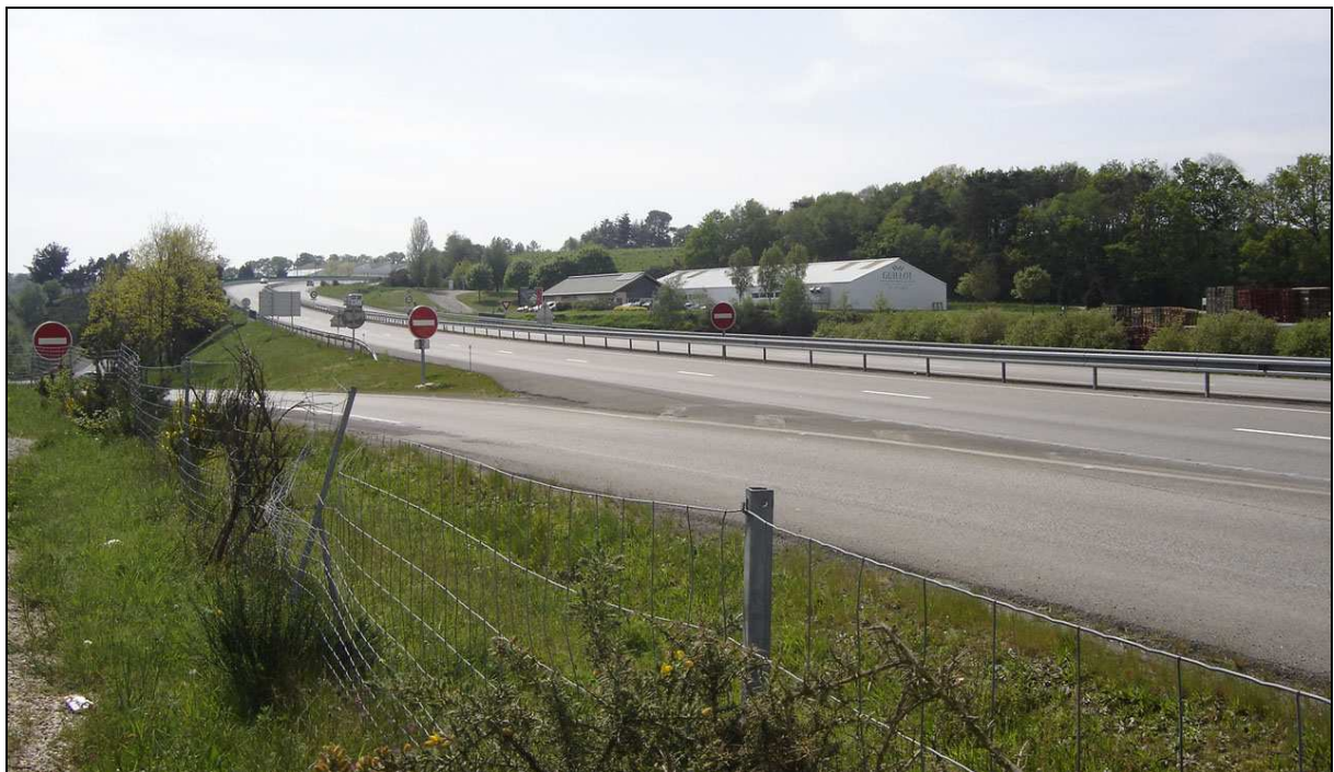
2X2 voies au niveau de l'échangeur de la CROIX BLANCHE
