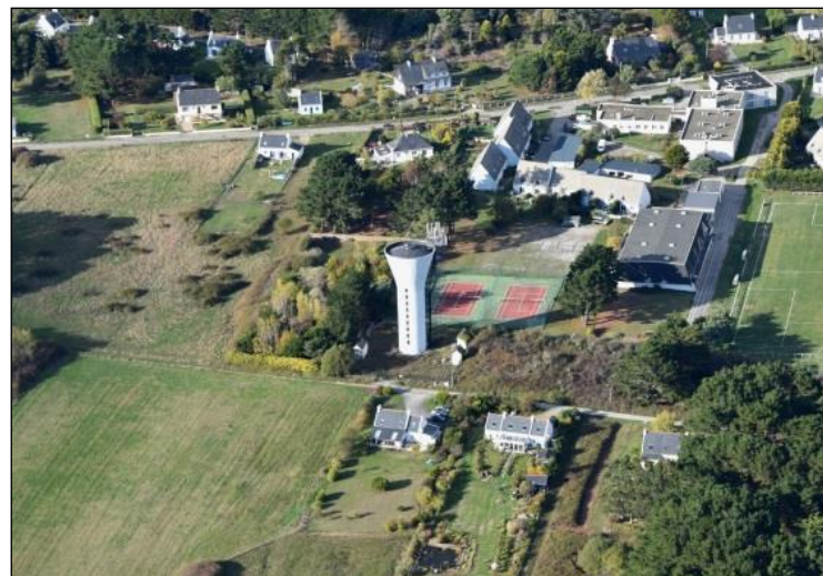
Château d'eau de Créhal (photo GEOS)
