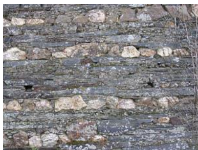
Maçonnerie de schiste avec insertion de blocs de quartz
