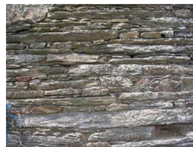
Appareillage de schiste
