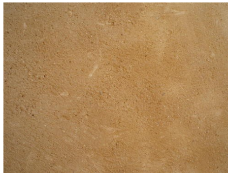
Exemple d'enduit de finition à la chaux
