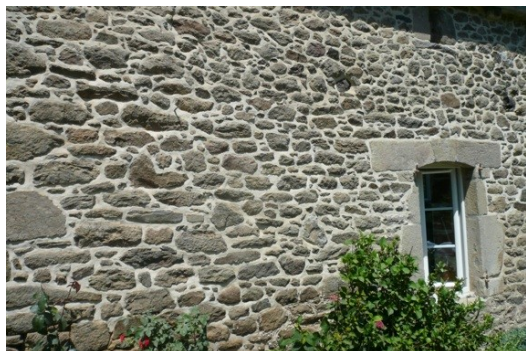
Exemple de joints extérieurs chaux/sable
