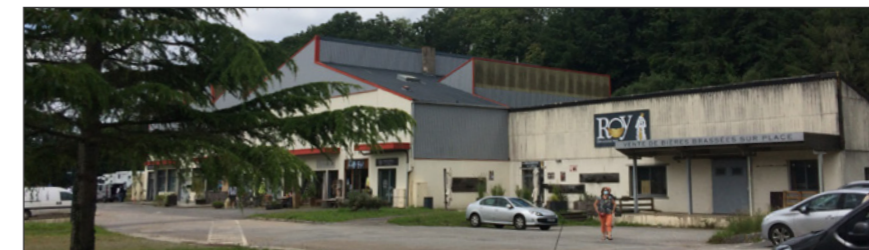
Fig. 105 : Photo du bâtiment « La Fabrique »
