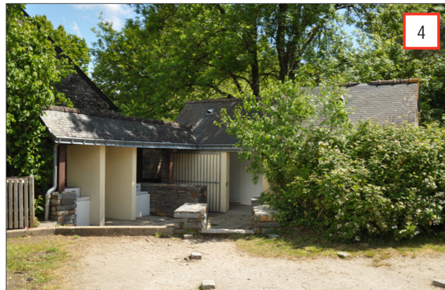
Fig. 20 : Bloc sanitaire public
