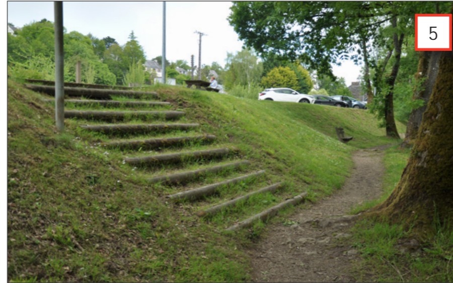
Fig. 23 : Emmarchement du parking au chemin bordant l'Aff
