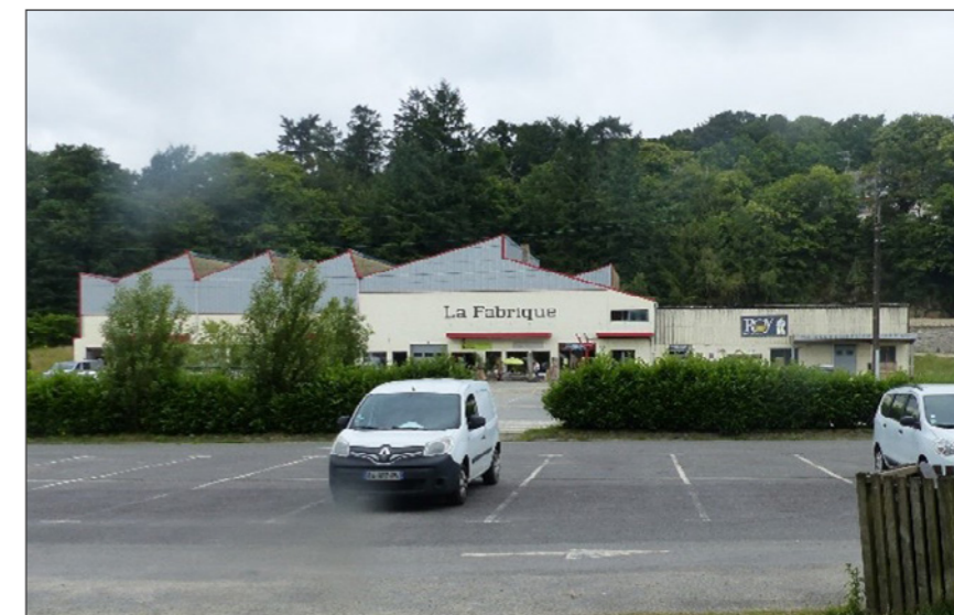
Fig. 39 : Constructions à surface dure (J4)
