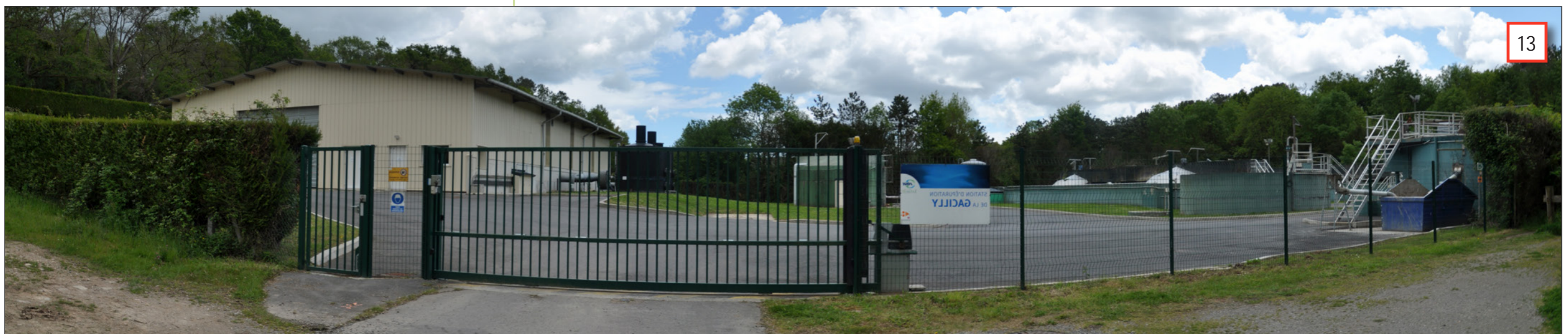
Fig. 36 : Station d'épuration des eaux usées
