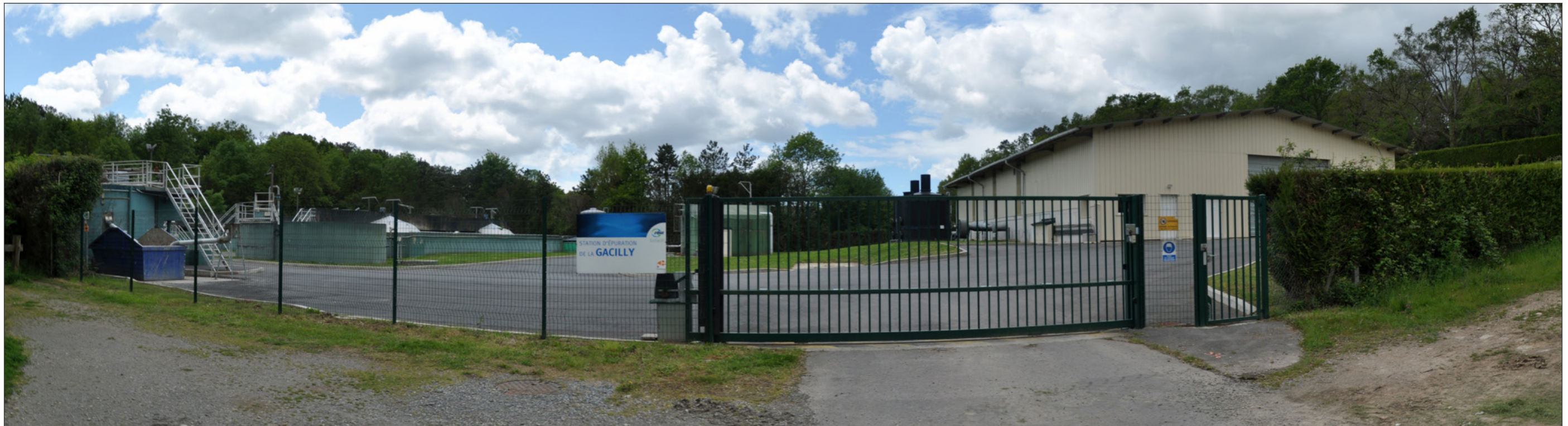
Fig. 64 : Station d'épuration des eaux usées de La Gacilly K.urban - DM.EAU • MAIRIE DE LA GACILLY
