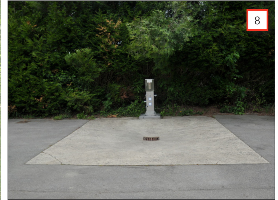
Fig. 21 : Aire de services pour camping-car
