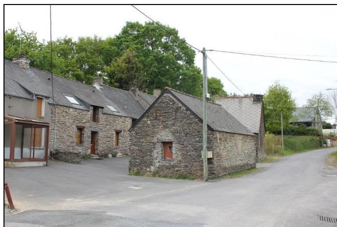
Configuration de petite cour avec annexe implantée en limite de l'espace public (rue de la Cordonnais).
