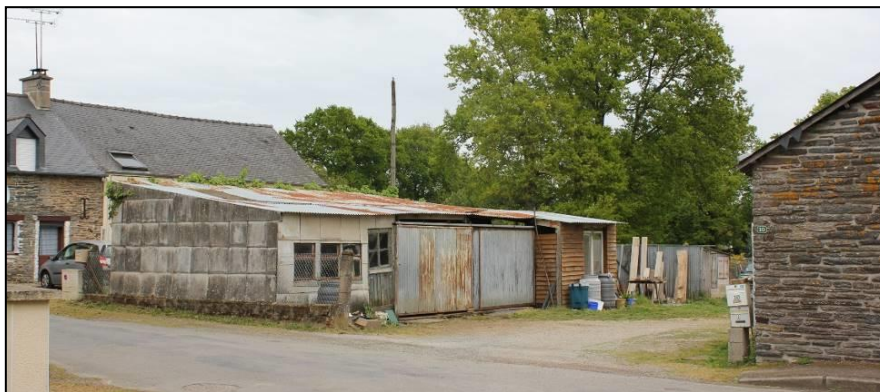
Annexe d'habitation en matériaux hétéroclites.
