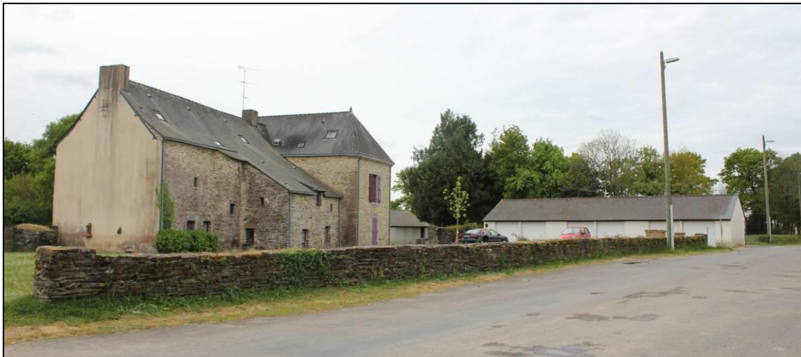
Ancien presbytère transformé en logements collectifs.
