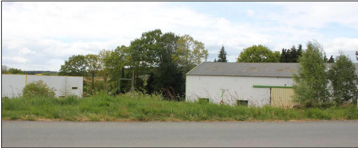
Hangar sur la rue de Poirier Vert : bardage métallique et toitures en fibrociment.
