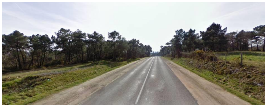
Passage de la RD 777 dans une continuité écologique (au sud de la Ville Macé)
