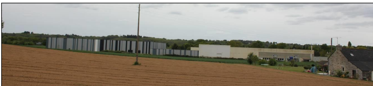
Bâtiment industriel (entreprise Saget) vu depuis la rue de La Fontaine.
