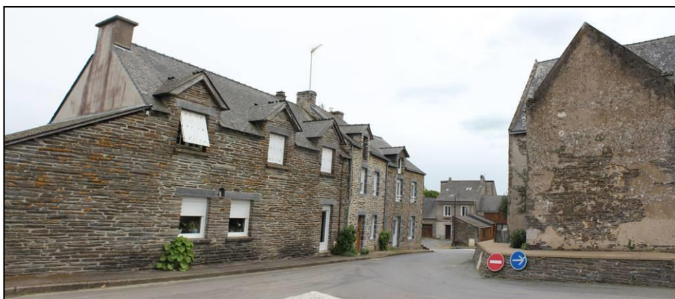
Rue de Sainte-Anne, pourtour de l'église : l'espace est complètement tenu par le bâti.
