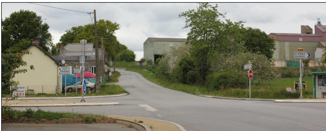
Carrefour entre la RD 149 et la rue de l'Oust.
