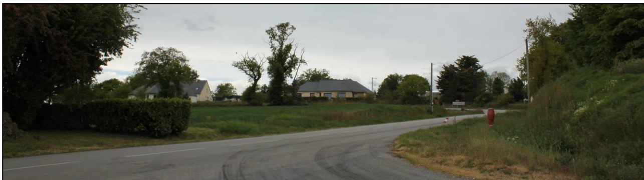
Entrée du bourg sud : vue sur les arrières de maisons. Absence d'un filtre paysager contextualisé.
