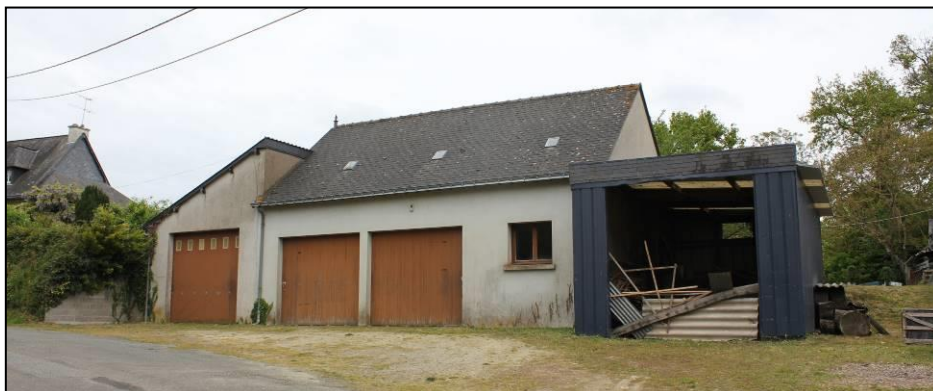
Extensions successives d'une annexe avec des volumes, des toitures et des matériaux différents.
