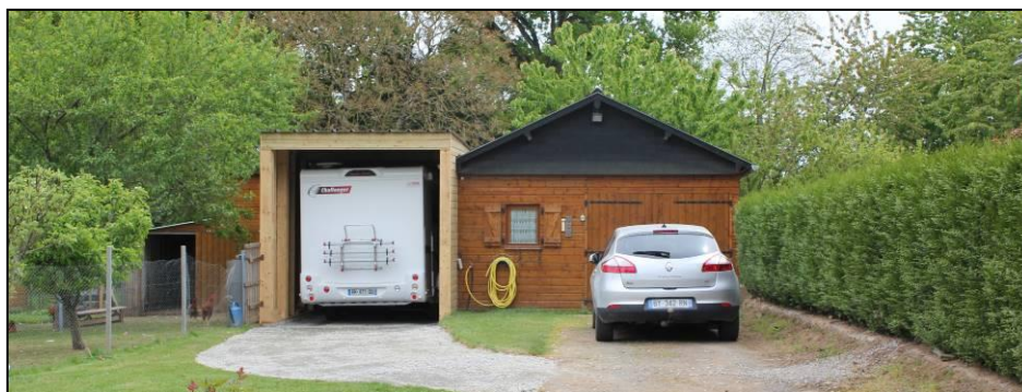
Exemple d'une extension d'annexe aux volumétries et toitures non cohérentes l'une avec l'autre.
