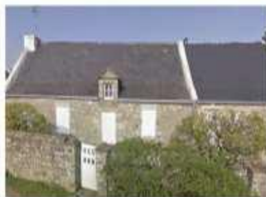
-N°2 Rue de Parpèze
