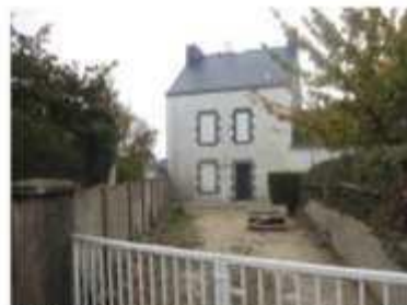
- N° 15 Avenue des Sinagots
