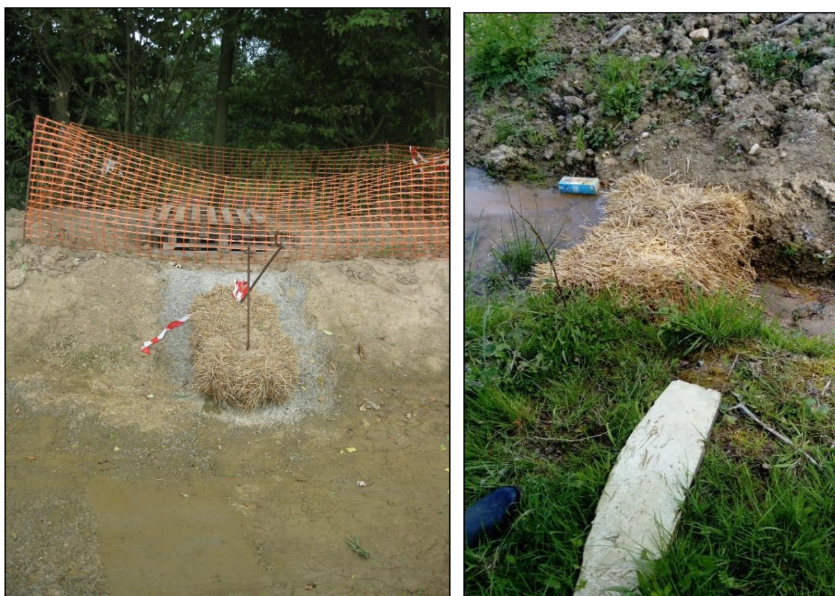
Figure 27 : Emplacements du filtre à particules fines (botte de paille) pendant la phase des travaux au niveau du bassin d'orage
