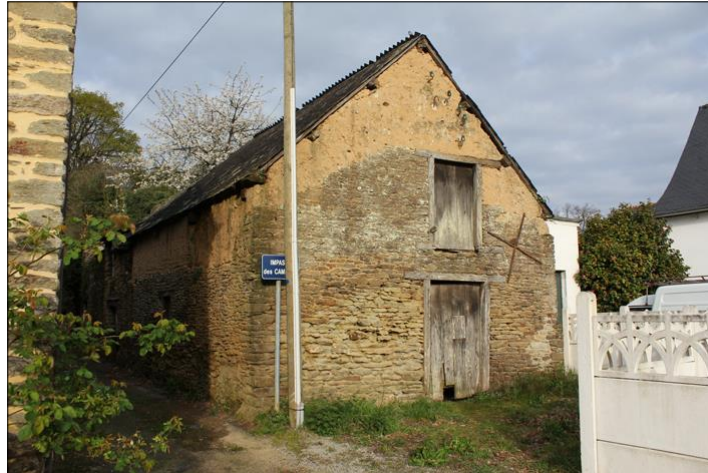
Ancienne bâtisse du bourg. Construction en pierres et terre pour la partie supérieure.
