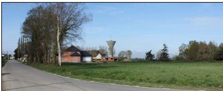
Présence visuelle constante du château d'eau qui apparaît comme un point de repère dans le paysage.
