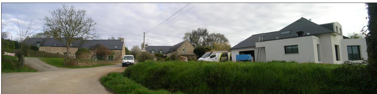
Au cœur un hameau de la Ville Robert : nouvelle maison en construction. Cette maison ne s'intègre pas esthétiquement et fonctionnellement au hameau. Elle présente un plan carré, des toitures à croupe, des enduits clairs et des baies horizontales.
