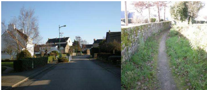
Des cheminements piétons en accompagnement de voie dans le bourg :
