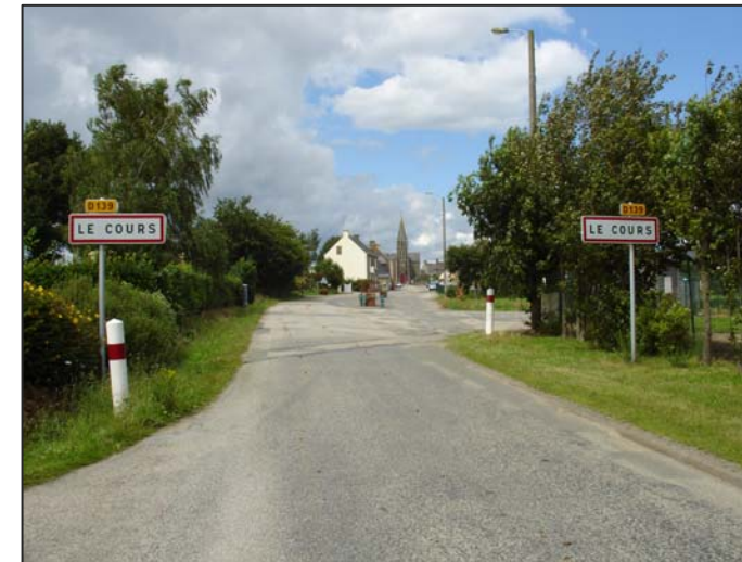
entrée de bourg Sud depuis la RD 139 perspective sur le clocher de l'église
